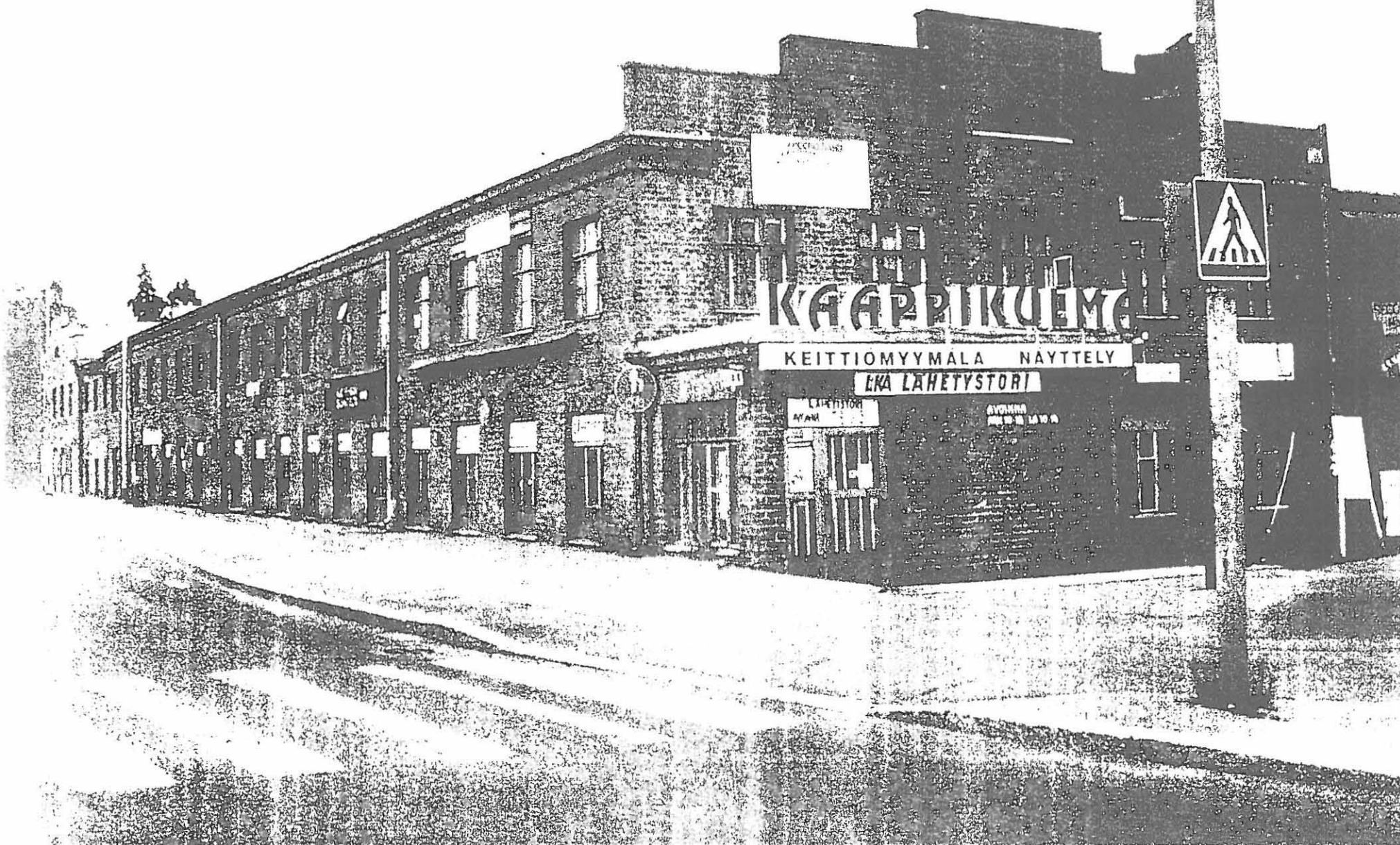
TEHTAAN VANHA KUTOMO KESÄKUUSSA 1998. KATUTASOA ON NOSTETTU LÄHES 1½ METRIÄ ALKUPERÄISESTÄ TASOSTA
