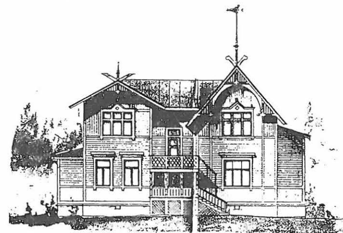
Huvilarakennus, Kalmarinkatu 5. Arkkitehti Allan Schulman v. 1898 (1.4.4), purettu
