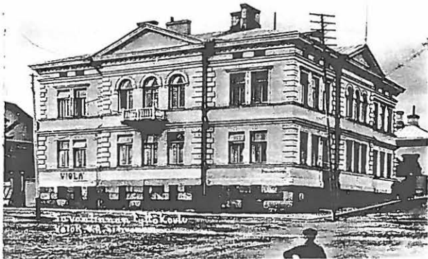
Puistokatu 1:n säilynyt kivitalo oli alunperin savonlinnalaisen rakennusmestari Kustaa Laukkanen asuintalo. Juorujen mukaan Laukkanen rakensi talonsa urakoimansa Lyseo-talon työmaalta yli jääneistä tiilistä. Rakennuksen suunnittelijaksi mainitaan Savonlinnan historiassa (Olli Vehviläinen) Allan Schulman. Kustaa Laukkanen mainitsee itse suunnitelleen talonsa. Ulkorakennusten piirustuksista löytyy Schulmanin signeeraus vuodelta (1895).
