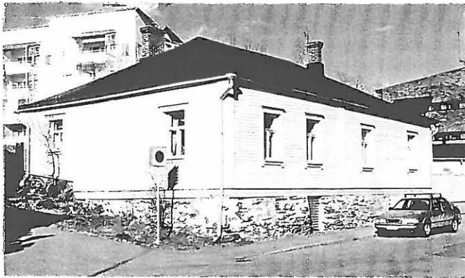
Linnankatu 27 säilynyt asuinrakennus 1820-luvulta on oikeastaan yhdistelmä venäläistä piirikuntakaupunkitaloa ja empire-rakentamista. Vanhaa perua on jyrkkä aumakatto mutta korkea sokkeli taas viittaa vuoden 1818 rakennusjärjestyksen antamiin ohjeisiin. Rakennuksen yksityiskohdat ovat niin niukkoja, ettei voi oikeastaan puhua mistään erityisistä tyylipiirteistä.
