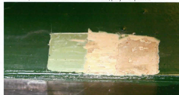
Kattoväri pääaulassa, pohjoinen pääaula
