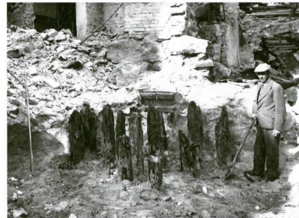
Alirakennusmestari ("underbyggmästare") Verner Johansson 5.9.1935 otetussa kuvassa vanhojen ja yläpäistään lahonneiden puupilareiden luona. 1930-luvun perustukset vietiin aiempaa syvemmälle. Kuva Erik Lucander.
