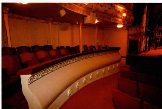
Permannon aitiio 1930-luvun asussaan. Alaosassa poistoilmanvaihtoon liittyvät aitiot
