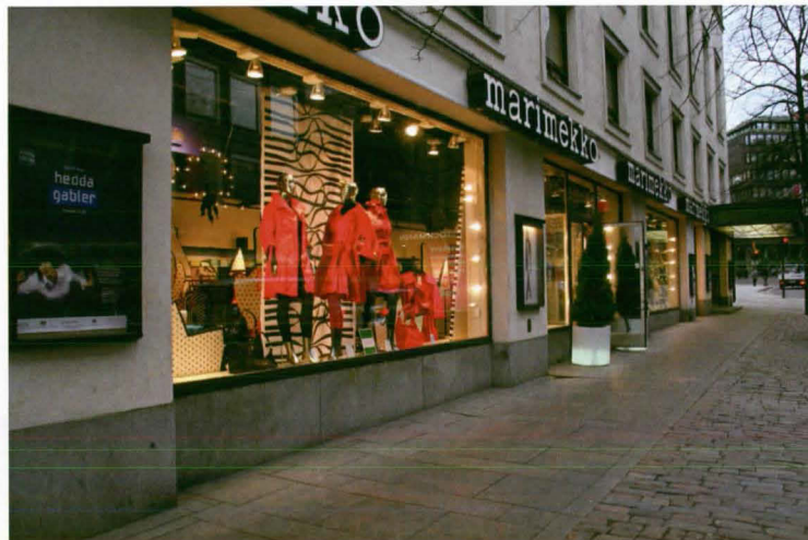
Pohjoisesplanadin Marimekon liikehuoneiston ikkunamuutoksessa yhdistettiin aiemmin 3-ruutuinen ikkuna yhdeksi vuonna 1995. 1/2008
