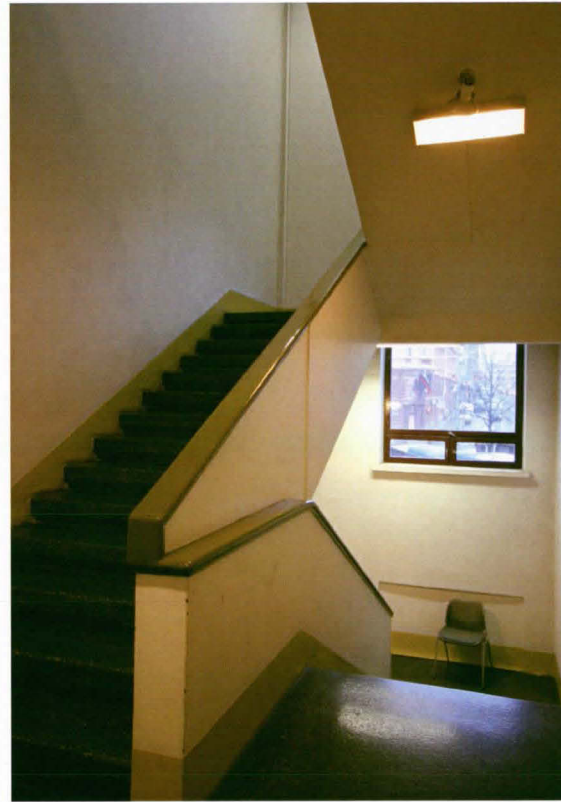
3. kerroksen kerrostaso. Betonikaiteiden päällä puinen ja nykyisin maalattu käsijohde
