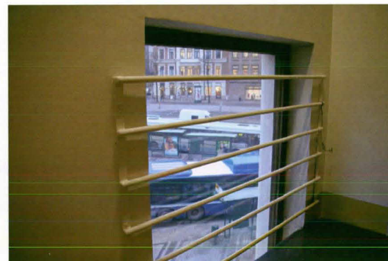
Suojakaide 3.-4. kerroksen lepotasolla, jossa korkea, kerrokset lävistävä ikkuna.
