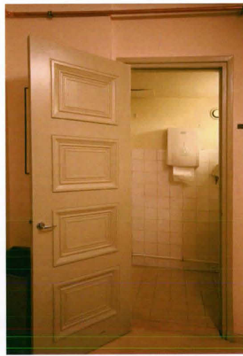
Esimerkki alkuperäisestä 1930-luvun asusta säilyneestä henkilökunnan WC-tilasta. Lattiasa beige-klinkerit, seinällä valkoinen 10x10 rinnan korkeudelle nousava lasitettu laatta.
