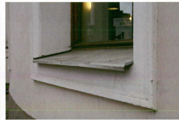
Pyöreän julkisivun ikkunoiden kehysli-toitus, uusittu 1991, kuvattu 11/2007
