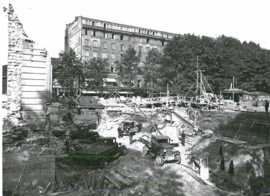
Kuva 5.9.1935. Opris on purettu ja uuden ravintolan peruskuoppaa kaivetaan. Kuva Erik Lucander.
