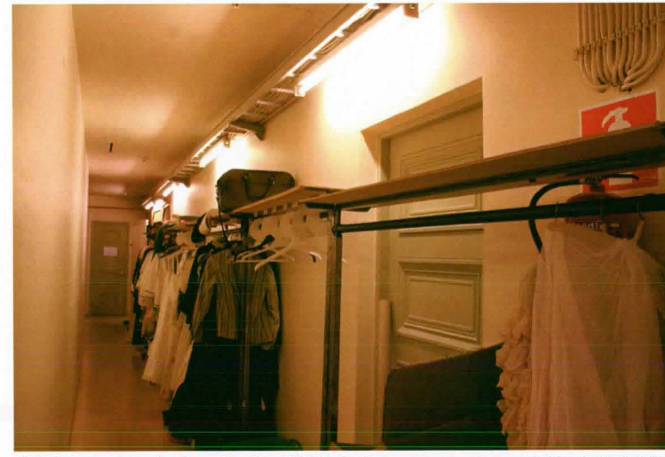
Yhdyskäytävä eteisaulan ja ruokasalin välillä, jonka kautta on voitu sivuuttaa juhlasali. Yhdyskäytävä toimii edelleen tässä käytössä, "Amoksen" takana. Harjoitussaliin ja WC:hen johtavat ovet nelipeilissä puoliranskalaisia ja käytävän päätteessä oleva ovi (vasen kuva) laakaovi jossa kehyslistat. Kaikki 1930-luvun art deco -klassismia. Vasemmanpuoleisen seinän sisällä on pitkä kapea tila jonka kautta lavasteet siirtyvät 5. kerroksen maalaamoon.
