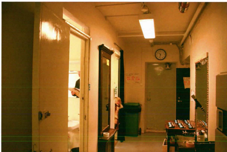
Nykyinen käytävä (2019) 1930-luvulla näyttämöjohdolle tarkoitettujen pukuhuoneiden (klädloge) kohdalla. Karmin päälle jäävästä valoaukosta voisi olettaa, että ovet, olkoonkin 1930-luvun laakaovi-mallia, on lisätty aukkoihin hieman myöhemmin. (kuva 0020)
