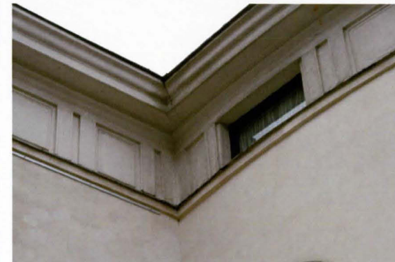
Kaarevan osan ja pohjoisen siiven välinen sisänurkka 11/2007
