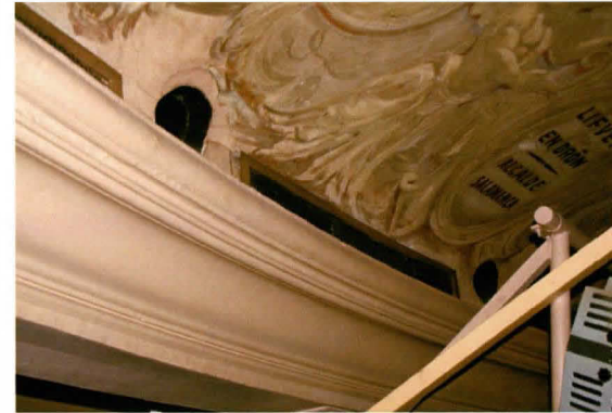
Tuloilmaritilöitä salin plafondin reuna-alueella. Ritilöiden välissä 1930-luvun valonheittetekniikkaa.
