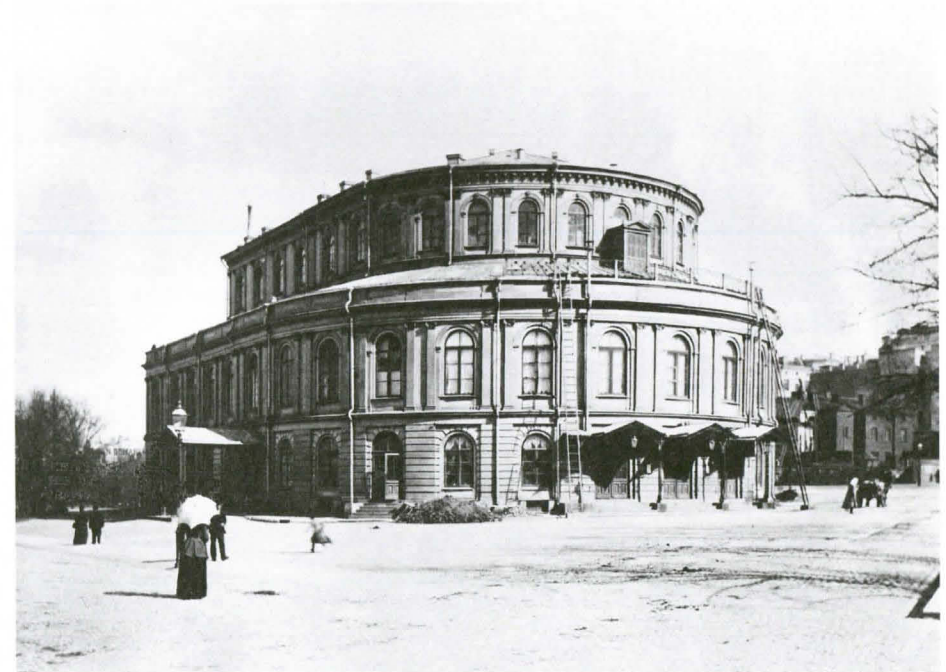
Stahlbergin 1800-luvun loppupuolella ottamassa kuvassa näkyy Gustaf Nyströmin 1888 suunnitelmien mukaan toteutettu kolmannen parven varapoistumisovi katolle sijoitettuna komeronä. SvTA.
