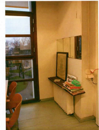
Entinen maalaamonjohtajan huone, nykyinen taukotila, jossa alkuperäinen puulautalattia, puiset jalkalistat ja radiaattori. Ikkunat on uusittu 2000-luvulla.
