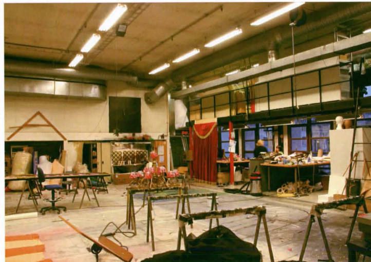
Myös toisella taustaseinällä on kookas ilmanvaihdonkonehuone 1980-luvulta.
