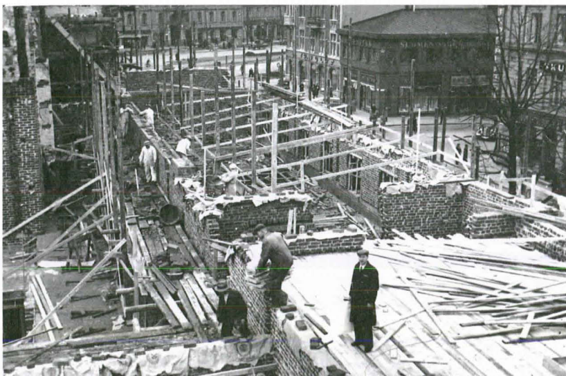
Kuva 22.10.1935. Sivusiipien muuraus nousee ripeässä tahdissa. Alemmassa kuvassa vastaava siipi kaksi päivää myöhemmin otetussa kuvassa. Huomaa, että esim. sivuseinät on nousseet noin puolikerrosta ja päähän on tehty välipohjaa varten puumuotti. Tiiliseinien päälle on laitettu pahvia tms. suojaamaan muuria liialta kastumiselta ja liialta kuivumiselta. Kuva Erik Lucander
