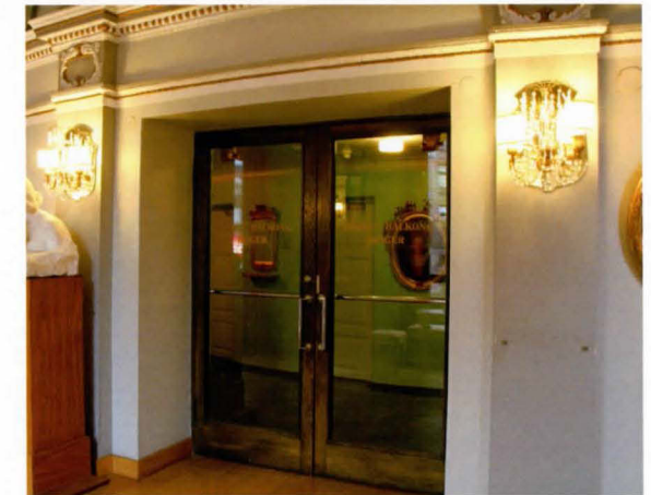
Lämpöistä oikealle ensiparvelle johtavat 1930-luvun pariiovet, petsattua ja lakattua tammea, kromatuin putkivetimin.
