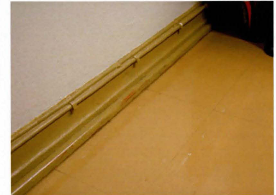
Entisessä teatterisäätien huoneessa (2024) on vielä jäljellä 1930-luvun maalattua puista jalkalista. Mattolista ja beige-kvartsiVinyyli-laatta ovat 1980-luvun muutostyön perua.
