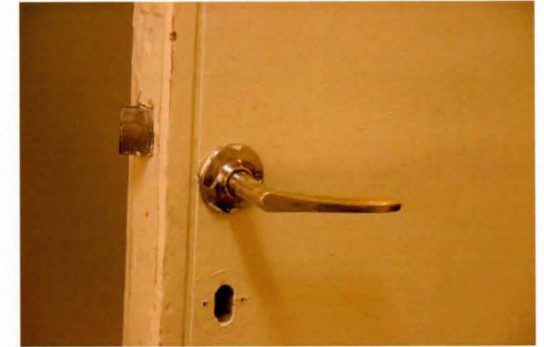
1930-luvun laakaovi ja kromattu ovipainike pukuhuoneessa.
