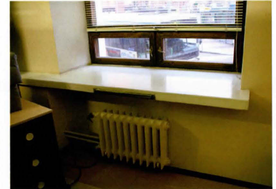
Entinen teatterisäätien huoneen (2024) ikkuna, jossa tyypilliset 1930-luvun elementit: tammi-ikkunat matalin tuuletusikkunoin, syvä ikkunapenkki jossa säädettävä raitisilmakanava ja lamelliradiaattori.
