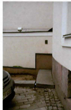
Vuonna 1991 tehdyn ulkoportaiden suojahuoneet, pohjoinen puoli 11/2007
