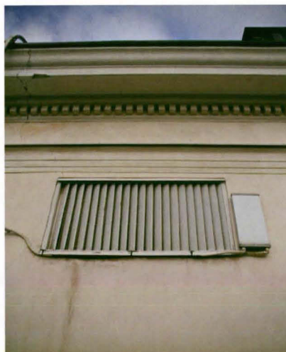
1980-luvulla tehty koneellisen ilmanvaihdon säleikkö ja langattoman puhelinverkon tukiasema. 11/2007
