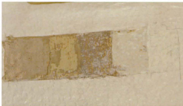
Seinäväri porrasaulan kohdalla, pohjoinen pääaula
