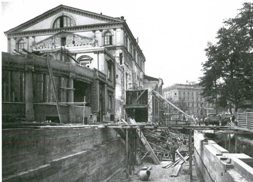
Kuva 13.8.1935. Opris-ravintolan kaareva osa on yhä paikallaan odottaen uuden 2-kerroksen rakentamista. Esplanadien puoleisten siipien maapaineseinät on valettu. Purkutyo on osittain kesken. Kuva Erik Lucander.
