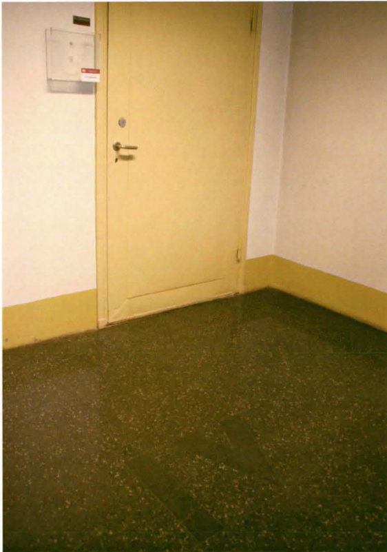
4. kerroksen kerrostaso. Mosaiikkibetonilattiaan on metallilistoin muodostettu tummempi kerrosnumero.
