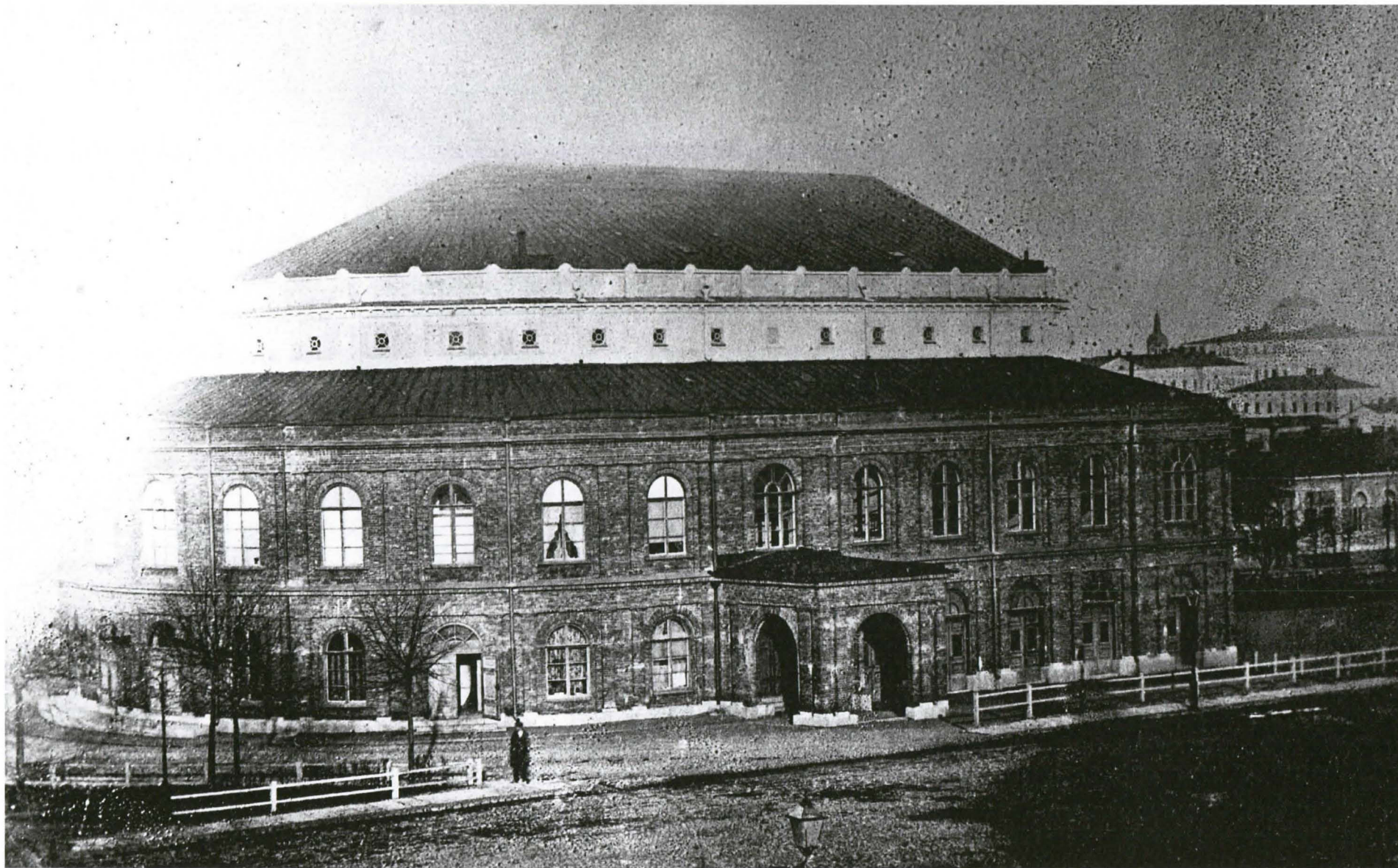
Chiewitzin vastavalmistunut teatteri, jonka alaosa oli vielä vailla rappausta. Viereisellä sivulla Chiewitzin suunnitelma julkisivujen rappauskoristeista jota ei ehditty saattaa valmiiksi ennen teatterin paloa 1863. SvTA.
