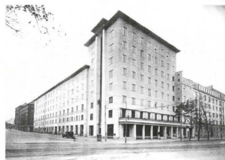
Kuva 41. Asunto Oy HOK Mannerheimintien ja Runeberginkadun kulmassa valmistumisvuonnaan 1929. Kaarlo Borgin suunnitelmassa voidaan nähdä jo joitakin funktionalismin piirteitä. Mannerheimintien puoleinen sisäänveto terasseineen, yksinkertainen julkisivujäsennöinti ja sisäpihalle rakennettu uloke pyöristettyine kulmineen ovat ominaisuuksia, jotka liitetään yleensä jo seuraavaan arkkitehtuuriperiodiin. — Valok. Olof Sundström 1929. HKM/KA.
