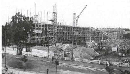
Kuva 43. Punaisen ristin sairaalaa rakennetaan Kammion sairaalan puutarhaan. — Valok. A. Pietinen 1931. MV.
