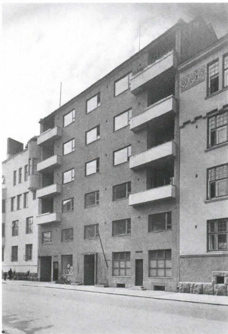
Kuva 47. Töölönkatu 42b, jonka Kaarlo Borg suunnitteli vuonna 1935, kuului kansainvälistä modernismia lähinnä olleeseen rakennustuotantoon Helsingissä. Tämän jälkeen ei Taka-Töölössä enää nähty koristeaiheita julkisivuissa. — Valok. A. Pietinen 1939. MV.
