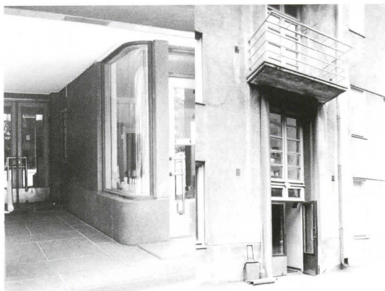
Kuvat 106 ja 107. Lisää portaalityyppejä. Vasemmalla porttikäytävään yhdistetty sisäänvedetty porrashuoneen sisäänkäynti Nordenskiöldinkatu 10, T. A. Elo 1937. Oikealla sisäänkäynti pihalta, jossa tuuletusparveke toimii myös sadekatoksena, Mannerheimintie 47, rkm Leuto A. Pajunen 1937. Vastavainlainen detaili löytyy Tukholman Hjorthagenin lamellikerrostaloista, jotka Hakon Ahlberg suunnitteli 1934–1935. — Valok. TL 1993.
