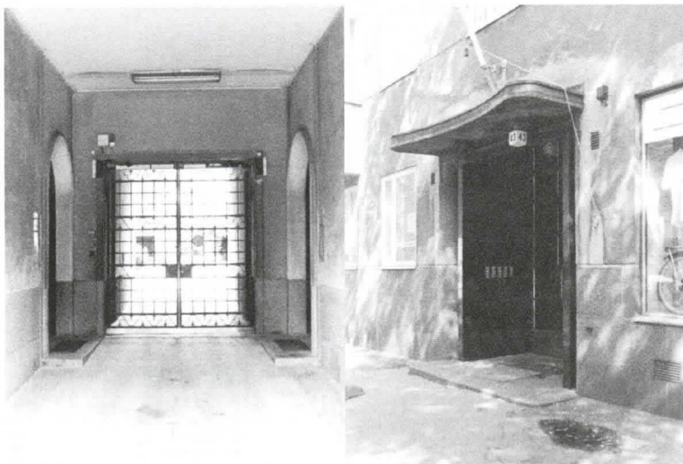
Kuvat 104 ja 105. Portaalityyppejä. Vasemmalla yhdistetty porttikäytävä ja käynnit kahteen porrashuoneeseen, Topeliuksenkatu 3a, Väinö Vähäkallio, Georg Jägerroos, Antero Pernaja, KK:n rak.osasto 1931. Oikeassa kuvassa on muotoiltu kuparilippa ja luonnonkiviset porttaalinpielet, Mechelininkatu 43, rkm Lauri Evert Mykkänen 1938. — Valok. TL 1993.
