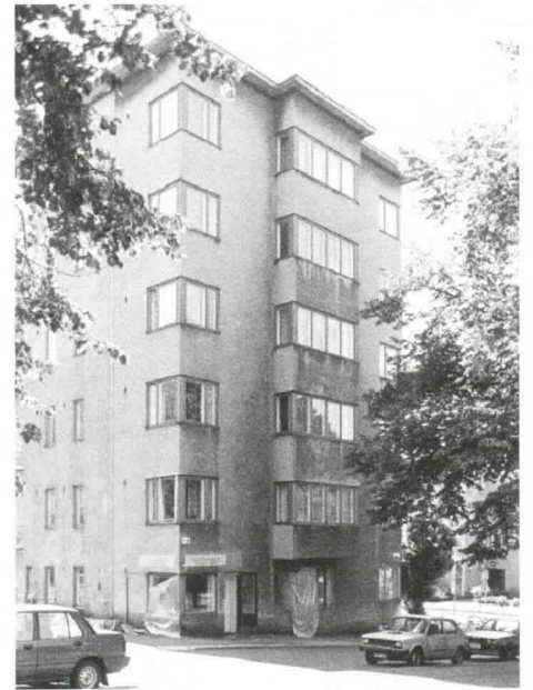
Kuva 100. Topeliuksenkatu 31:n päädyn suorakaide-erkkeri ja kulmaikkunat. Molemmat tyypillisiä Taka-Töölön pohjoisosien puolisoljettujen kortteleiden päätytaloille. Rakennuksen ovat suunnitelleet arkkitehti Arvo O. Aalto ja rakennusmestari Yrjö Vuorinen vuonna 1936. — Valok. TL 1993.
