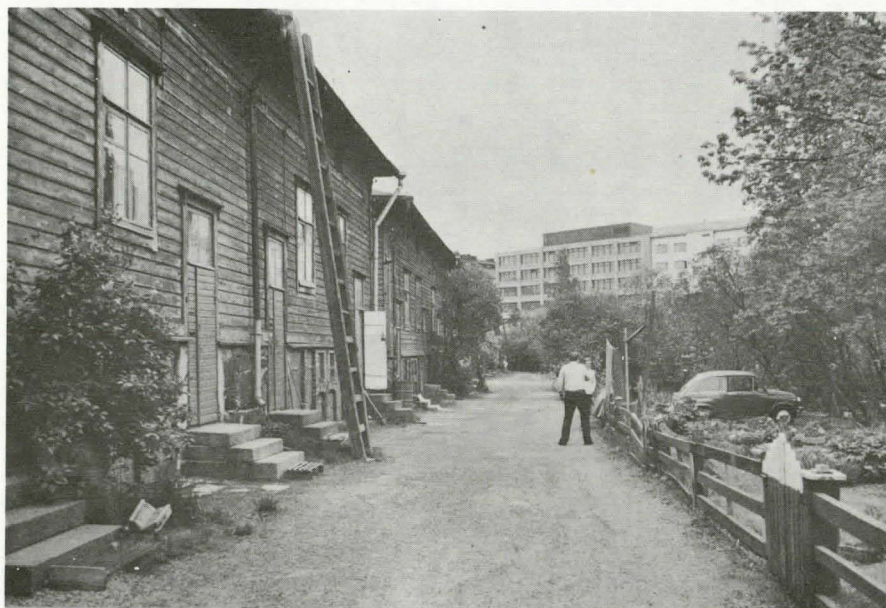
14A Pihajulkisivuja (kaupunginmuseo)
