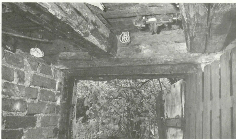
15B Kellarin rakenteita (S. Rista)
