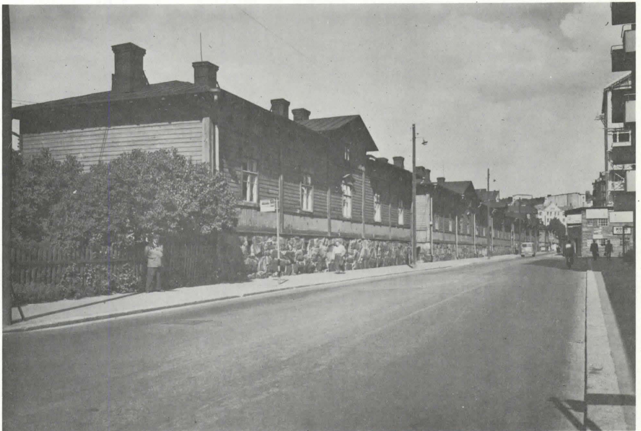
1B Ruoholahdenkadun puoleinen rakennusrivi ennen purkamista. Kuva vuodelta 1954 (kaupunginmuseo)
