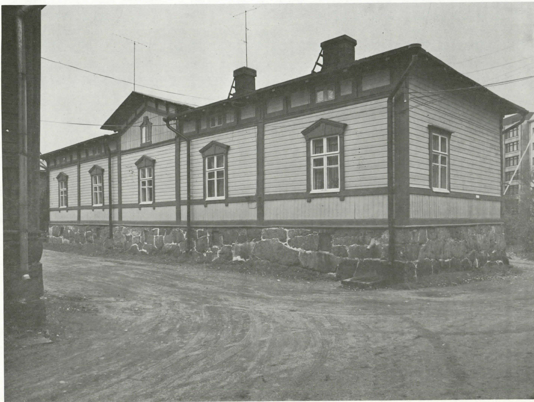
16 S-rakennus maalattiin ja lahonneet osat paikattiin syksyllä 1975 (S. Rista)
