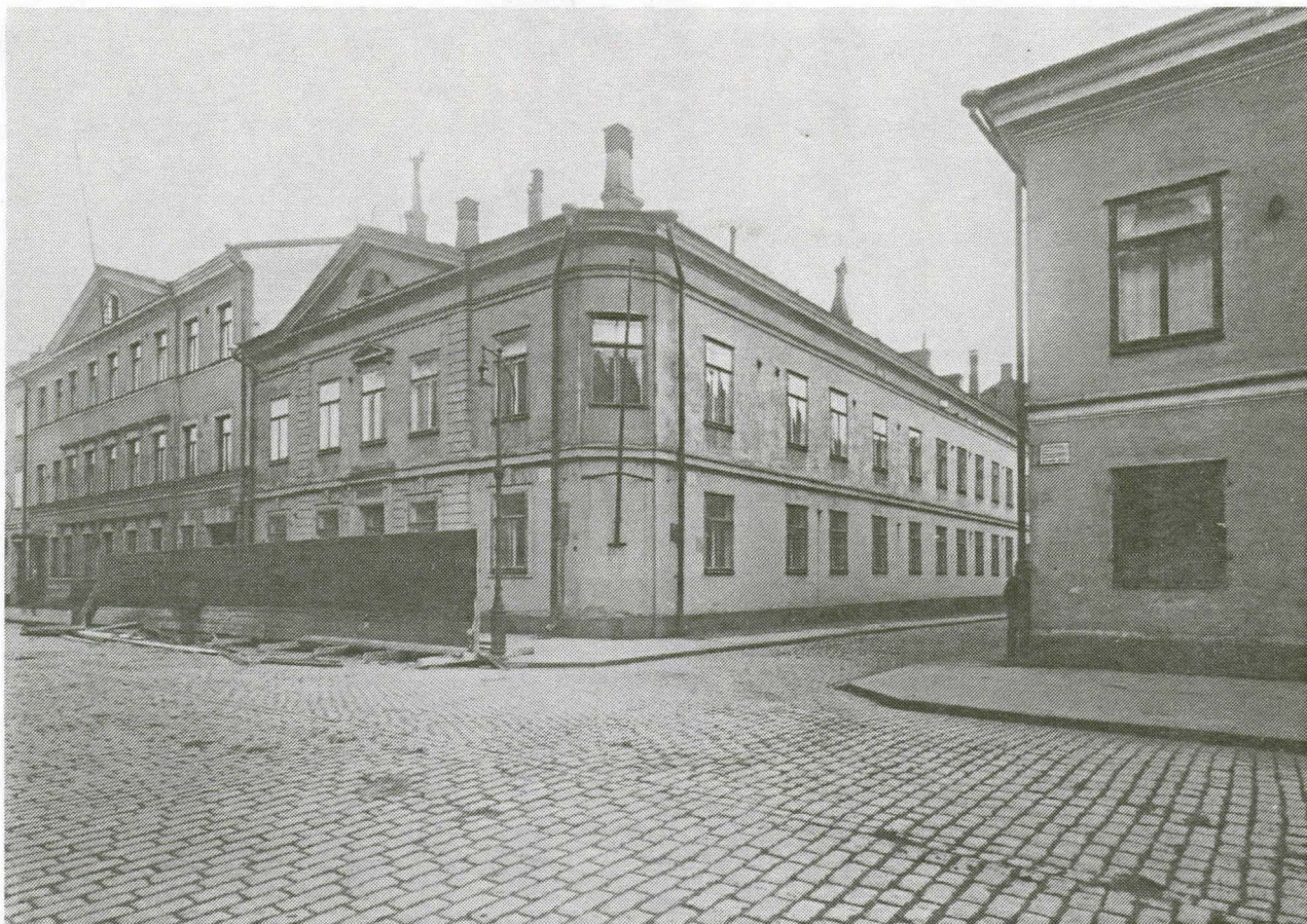
Kuva 5. Aleksanterinkatu 10 - Helenankatu 5 vuonna 1914 ennen korotusta ja julkisivun muutosta. Huomaa Helenankadun fasadissa ikkunakoon pieneneminen neljänneestä ikkuna-akselista lähtien. Se osoittaa Aleksanterinkadun puoleisen rungon ja Helenankadun siiven rajan. Valok. Helsingin kaupunginmuseon kuva-arkisto.
