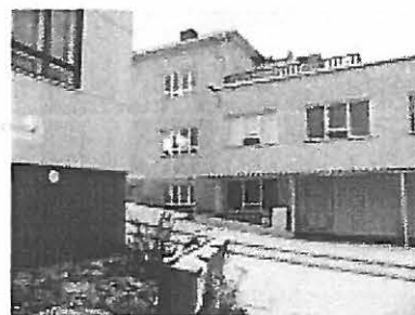
Sähköntalon siipiosan liityminen vanhempaan osaan
