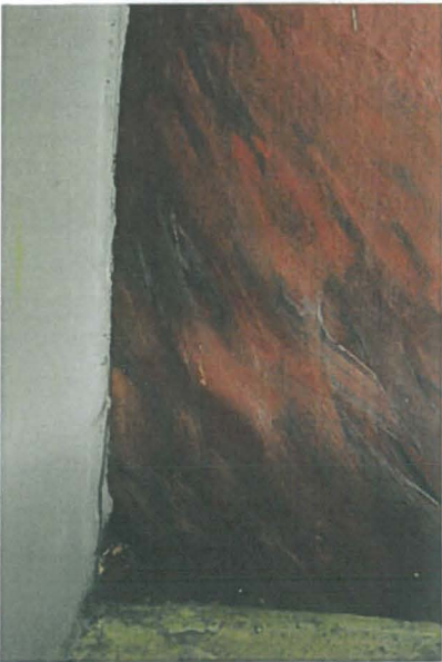
Vasen alareuna, jänisliima on injektoitu kankaan ja seinän väliin.
