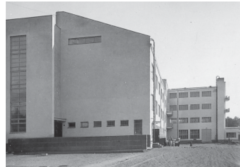
Kasarmin pohjoispääty ja pihaa ennen autojen pesutelineiden rakentamista. SRM
