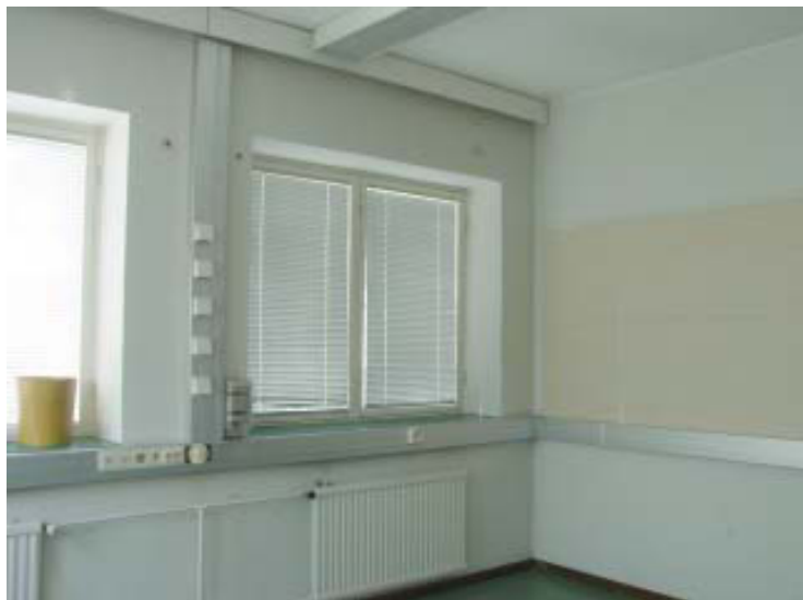
Itäpäädyn toimistopääty on tilana pysynyt samanhenkisenä. Pintoja ja varsinkin talotekniikkaa on uusittu. MV. Jetsonen.
