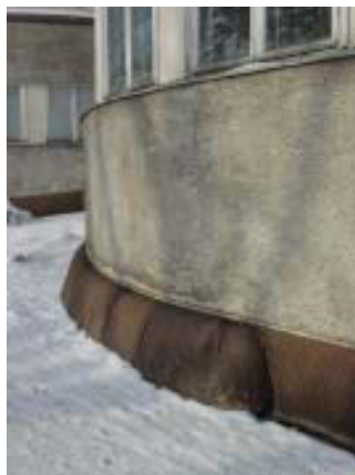
Pyörästetty sokkelidetilji. MV. Jetsonen.
