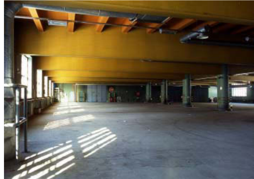
Suuren yhtenäisen tilan vaikuttavuutta korostavat kantavien rakenteiden jyrkkyys ja pitkät jännevälit. Kahdesta suunnasta tuleva valo on myös tilassa tärkeää. MV. Tirilä.
