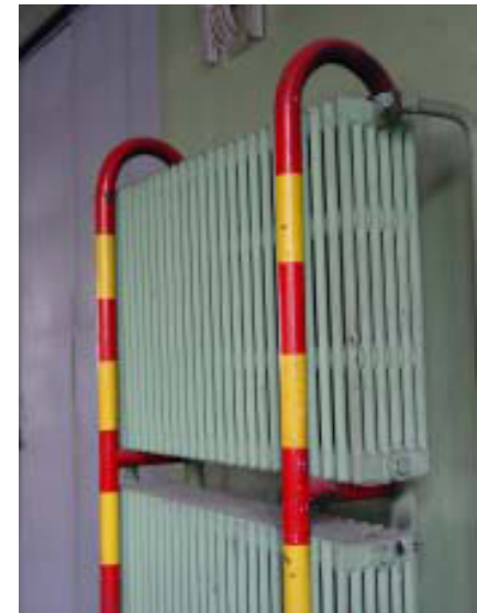
Autohallin pattereita törmäyssuojineen. MV. Jetsonen.
