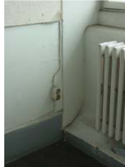
Lamellipatteri hygienia-tilassa. MV. Jetsonen.
