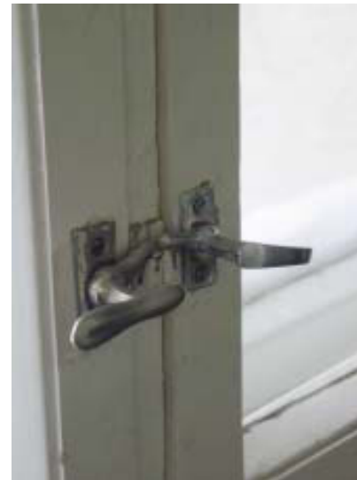
Kaksi niklattua helatyyppeä, jotka toimivat sekä kääntösulkimina että kiinnikkeinä. MV. Jetsonen.
