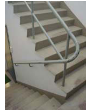
Mechelininkadun puoleisessa porrashuoneessa on jäljellä alkuperäisiä rakennusosia. MV. Jetsonen.
