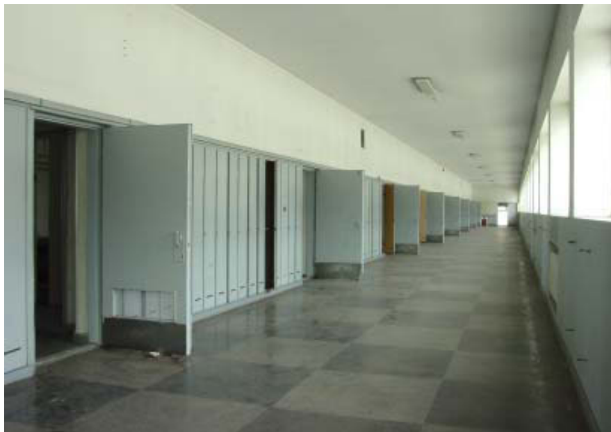
Käytävät ovat säilyneet ilmeeltään ja yksityiskohdiltaan alkuperäisinä. Virtaviivaista tilaa vahvistavat nauhaikkuna sekä linjakas kaappiseinä. MV. Tirilä.
