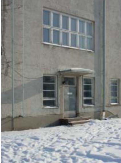
Vartiotilan sisäänkäynnin yläpuolella tupaikkuna. MV. Jetsonen.
