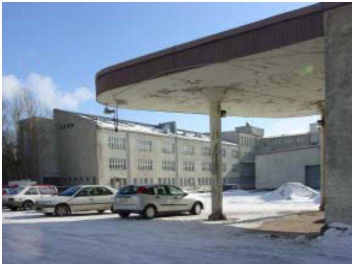
Keskeisen piha-alueen elementtejä: kasarmi, autohallin pääty ja huoltoaseman katos. MV. Tirilä.
