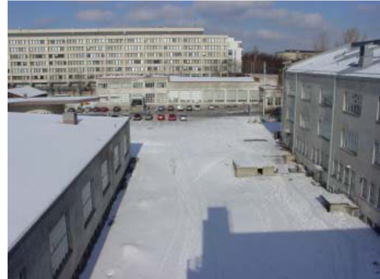
Rakennusten välinen piha-alue. MV. Tirilä.
