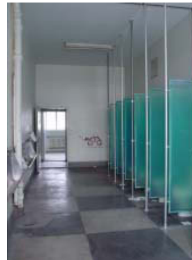
Alkuperäinen mosaikkibetonilattia, uudet wc - kalusteet väliseiniineen. MV. Jetsonen.
