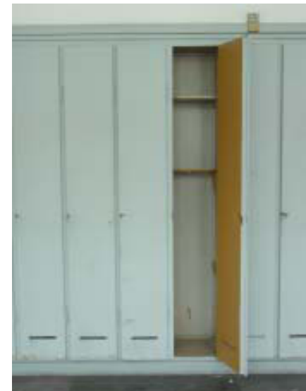
Tupakäytävien tuuletusraoliset vaatekaapit. MV. Jetsonen.
