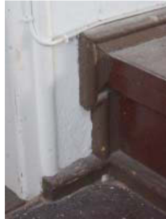
Opetussalin puujalkalista, esimerkki huolellisesta yksityiskohtien suunnittelusta. MV. Jetsonen.
