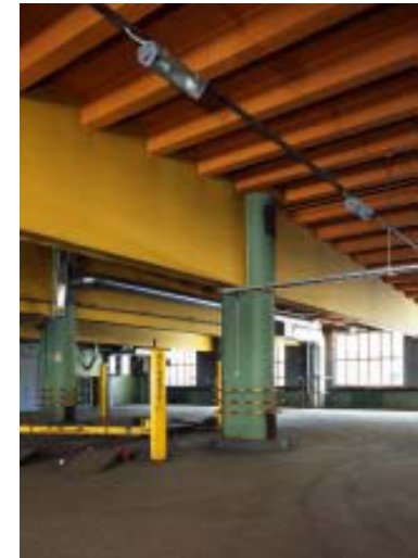
Pilarin kyljissä on puolipyöreä IV-hormi ja vanhoja IV-säleikköjä. MV. Tirilä.
