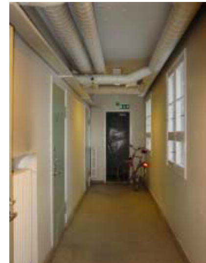
Autohallin käytävällä uusia IV-putkia ja sähköhyllyjä. MV. Jetsonen.
