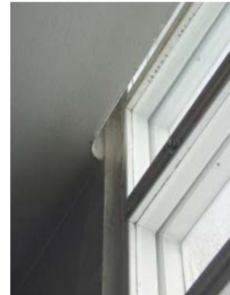
Pääporrashuoneen ikkuna jatkuu yhtenäisenä kerrosten läpi. MV. Jetsonen.
