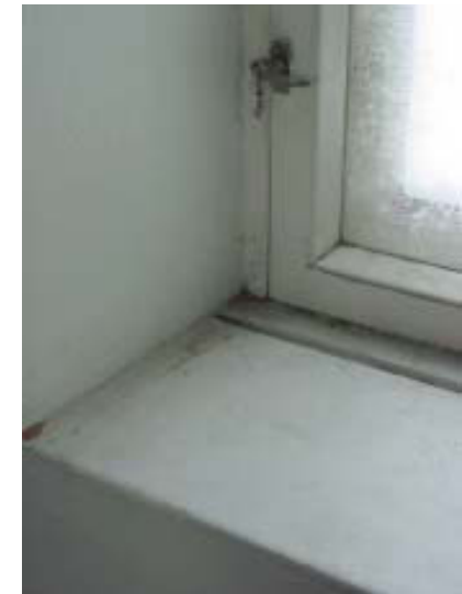
Ikkunasyvennys urituksineen. MV. Jetsonen.
