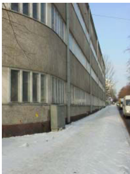
Julkisivun ilme Mechelininkadulle on voimakkaan horisontaalinen. MV. Jetsonen.
