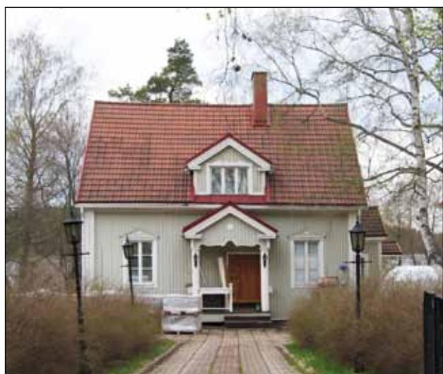
Sarjaksen talo Rantatiellä kuuluu 1900-luvun alun käsityöläisten ja virkamiesten rakentamaan asuinalueeseen. Rakennuksessa on onnistuttu säilyttämään alkuperäinen arkkitehtuuri. Kuvaaja Juuso Väisänen 2007.
