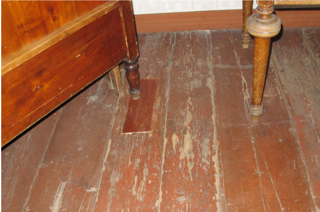
Kuva 4. Isännänkamarin lattian puupaikkaus.
