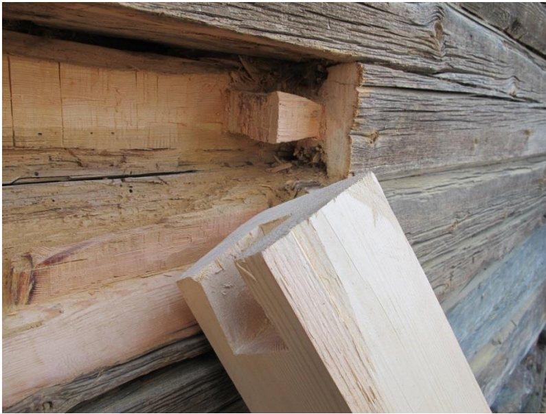
Kuva 7. Neljännen hirsikerran paikkapalan molemmissa päissä on piilosinkkaliitos.
