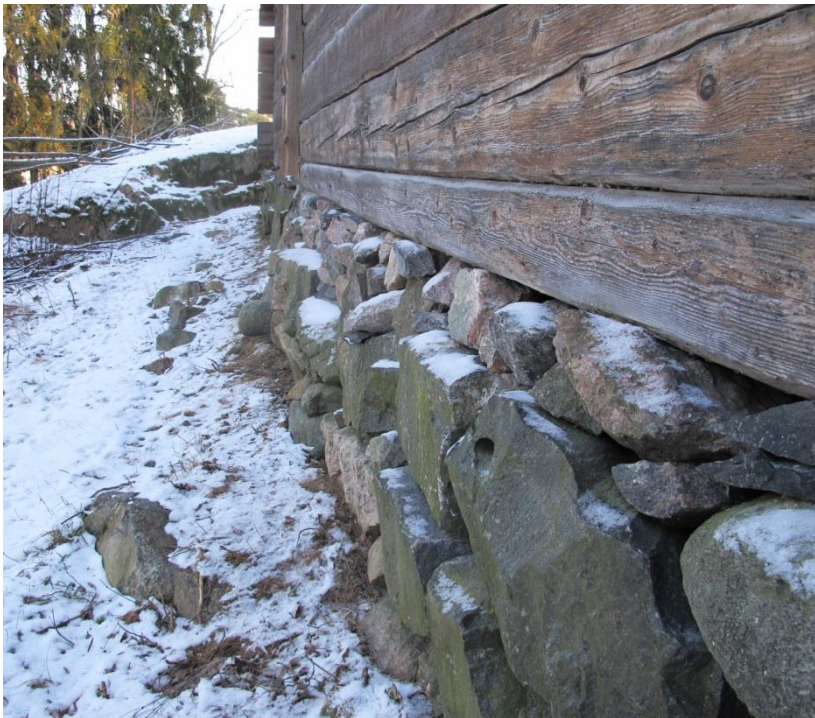
Kuva 1. Pohjoispuolen paranneltua kivijalkaa.
