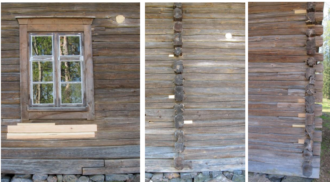
Kuva 6. Pohjoisseinän hirsien paikkaukset.
