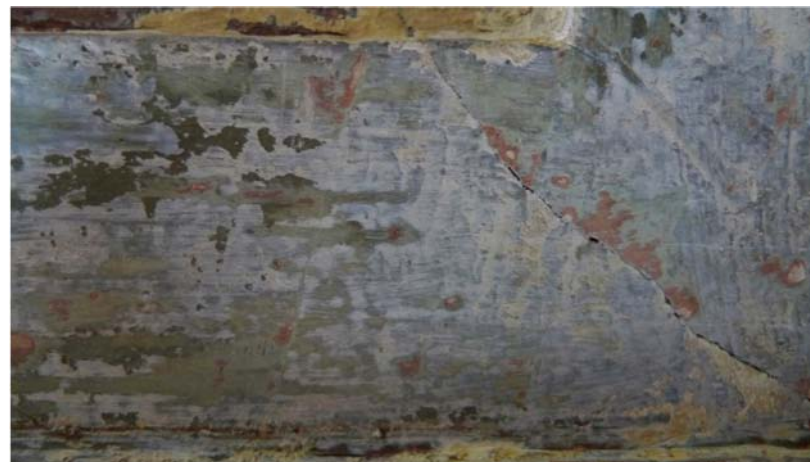
Puhdistamaton vihreä listaväri jossa vaalea eristekerros päällä. Pinnassa raapimajälkiä, jolloin vihreä väri on osittain menettänyt sävyvoimaansa ja alla oleva punertava väri on tullut esille.
