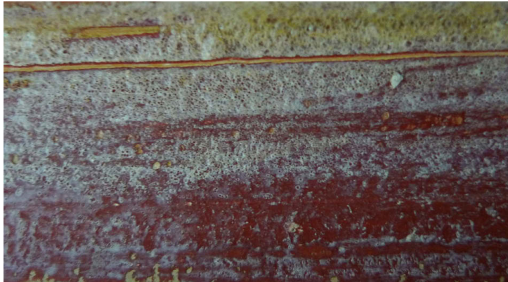
Yksityiskohtakuva listasta, jonka pinnalla on runsaasti kuivunutta maalinpoistoainetta. Maalinpoistoaine siklattiin pinnalta pois kirurginveitsellä.
