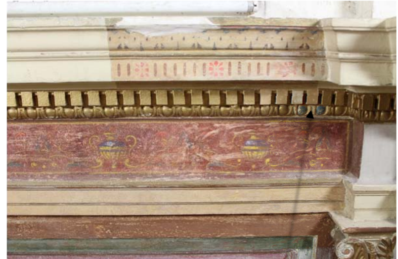
Puhdistettu yläpalkisto.
