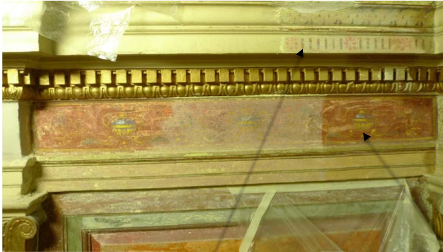
Yläpalkisto, jossa puhdistustyö käynnissä. Friisin keskellä eristekerros poistamatta.
