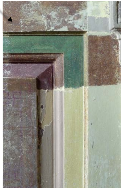
Koealue, jossa testattiin kuinka kaikki maali-kerrokset saadaan poistettua. Kuvan oikeassa alareunassa on vielä kaikki maali-kerrokset tallessa.
