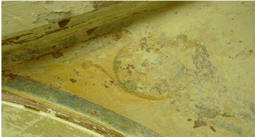
Sisääntuloaulan katto. Puhdistustyötä aloitettu vasemmasta nurkasta.
