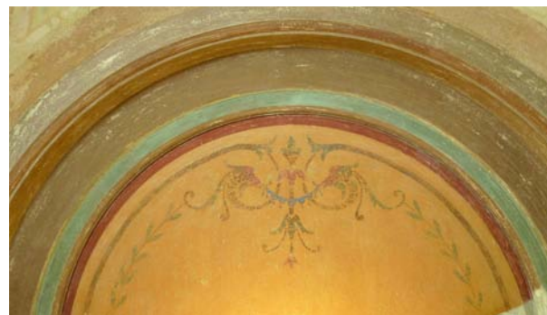
Tasanteen seinäpeilin yläosa puhdistettuna.
