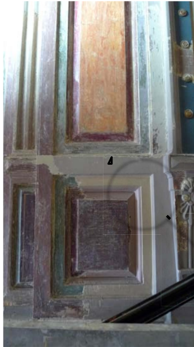
Sisääntuloaulan seinänosa ennen toimenpiteitä. Ympyröity alue on koealue, johon suoritettiin kaikkien maali-kerrosten poistokoe.
