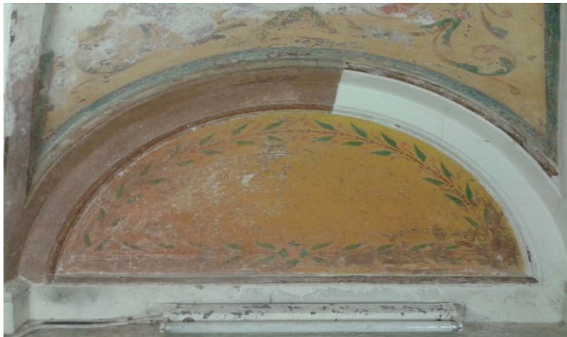
Lunetti puhdistuksen ja listojen osittaisen kuorimisen jälkeen.
