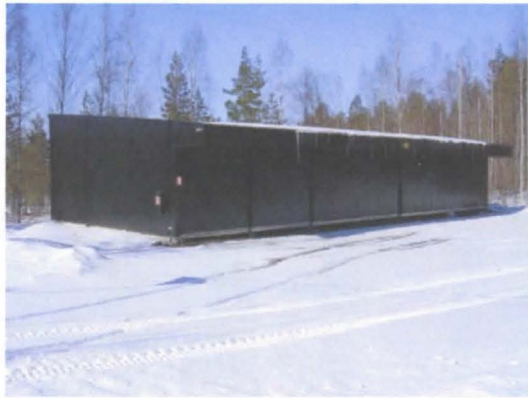
Kuva: Useimmat Arkkitehti Risto Kaurian suunnitteleman vanhan tuotantoalueen rakennuskanta on nykyisin varastokäytössä. Muutaman rakennuksen julkisivut on kokonaan pellitetty 1997 – 1999.
