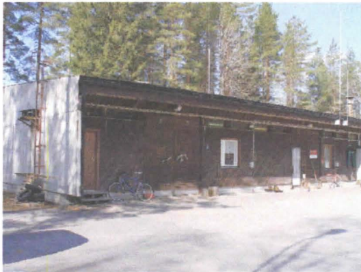
Kuva: Alkujaan tullikamarina toimineen 1960-luvun varastorakennuksen julkisivut ovat säilyneet alkuperäisinä. Rakennus kunnostetaan lähitulevaisuudessa logistiikkakeskukseksi.
