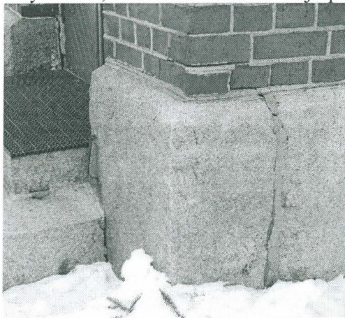
Jo aiemmin korjattu kivijalan nurkka.
