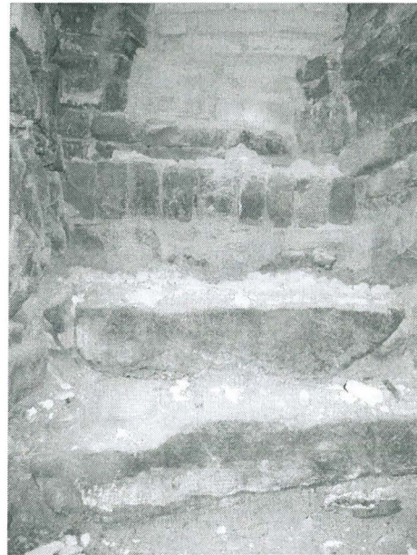
Portaat ja umpeen muuratun oviaukon alaosa.
