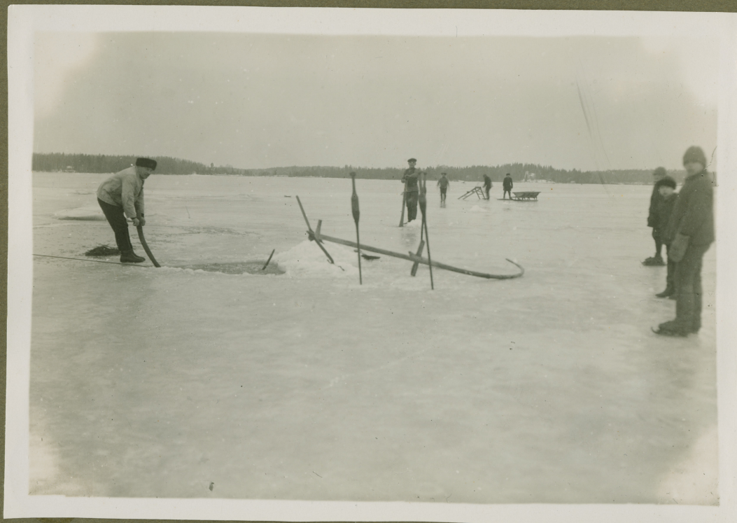
N o 12. Noidiäki a' Olaike fjärd, Bergå Nätlinan flöts under isen från vaktlinan med tillhjälp av stängen "pakan" och "hingan". foto. Ernst Segerström 29/12 22.
