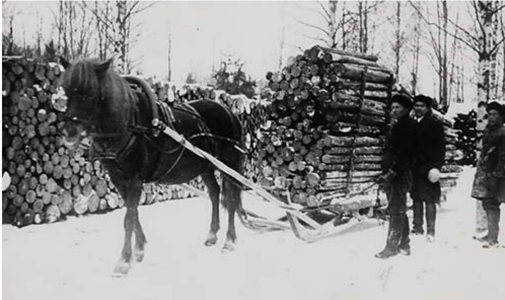
Puukuorma Ahlströmin työmaalla Pielaveden Talluskylän seudulla 1930-luvulla.
