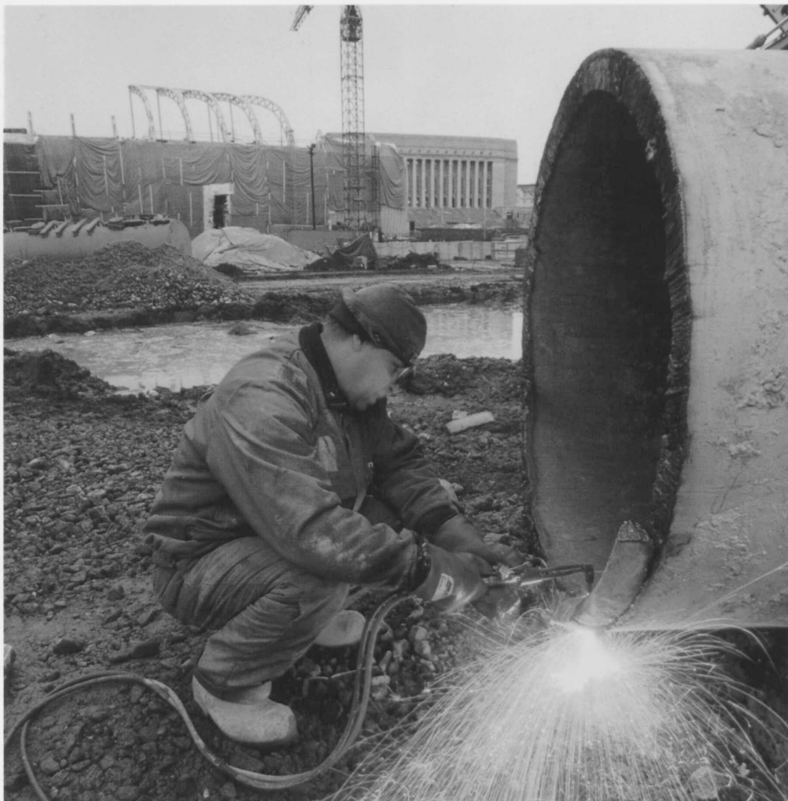
Sanomahusets grund har förstärkts med 240 grävpålar.
