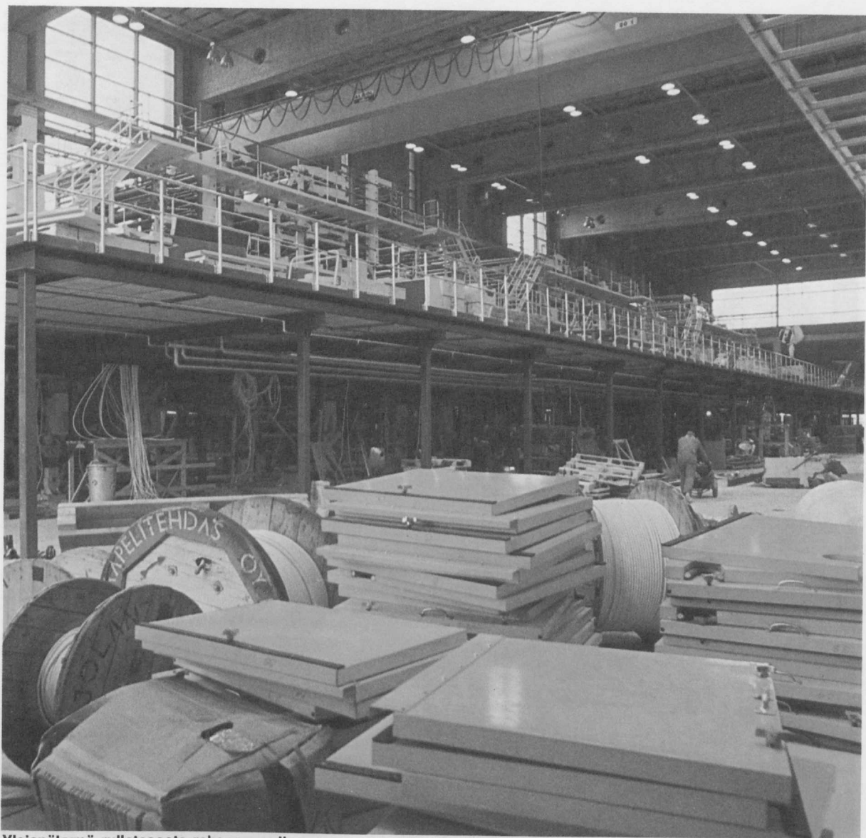
Yleisnäkymä rullatasosta rakennusvaiheessa
