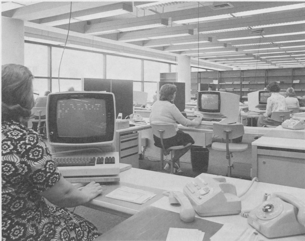
Tilausliikenneosasto sai uudet tilat Itälahdenkadulta Lauttasaaresta. Kuvan näyttöpäite on kääntyvällä alustalla. Tästä alustakeksinnöstä yhtiö myönsi ensimmäisen konttorihenkilökunnalle annetun aloitepalkkion. Pyörivän alustan ansiosta laitetta voi joustavasti käyttää useampi henkilö.
